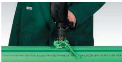
Provrtání stěny potrubí
