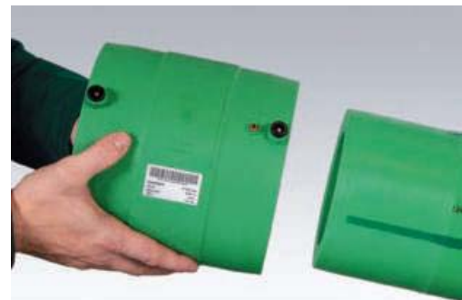
Nasunúť spojku na koniec potrubia
