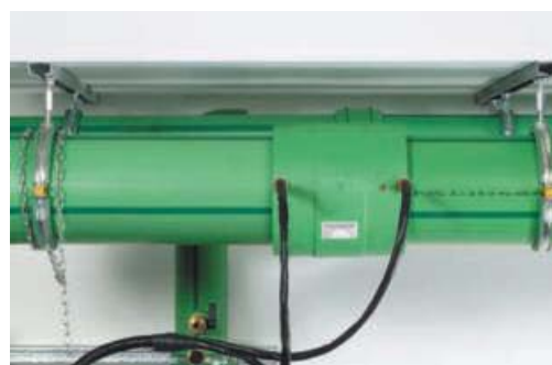
Zvárací prístroj pripojiť na kontakty spojky. Zvárací proces zahájiť. Ochladíť. Hotovo!
