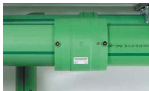
Potom vsunieme potrubie druhou, tiež opracovanou a očistenou stranou do spojky
