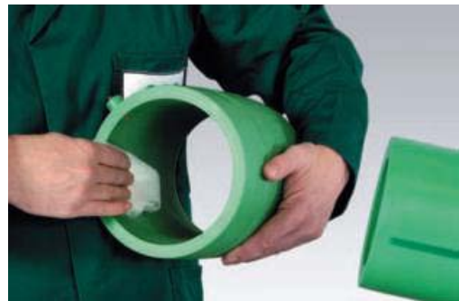
Očistiť vnútornú plochu elektrospojky
