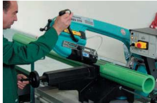
Pred zváraním upravíme 160mm potrubie na požadovanú dĺžku
