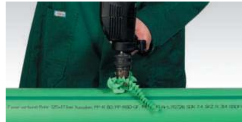
Prevrtánie steny potrubia
