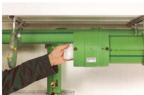
Elektrospojku znovu očistiť
