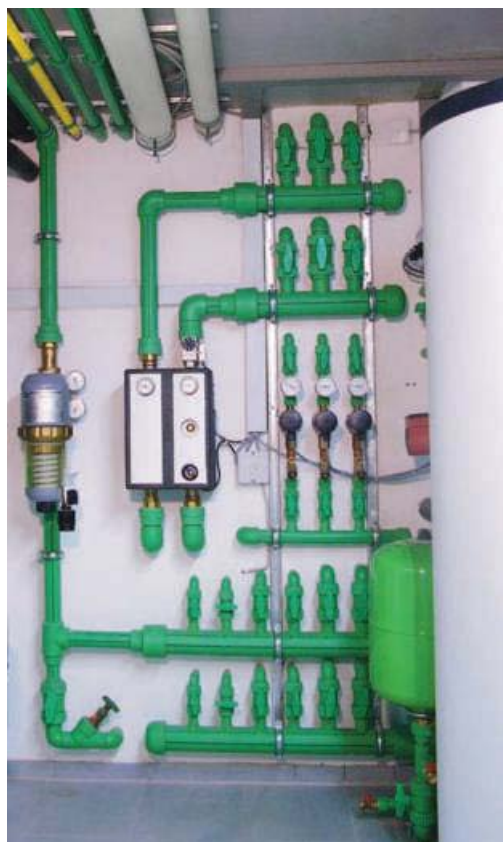
Realizácia rozdeľovačov v sanitárnej a tepelnej technike rodinných domov
