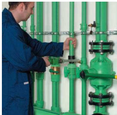
Výroba rozdeľovača pomocou fusiotherm® potrubia so sklovláknami a veľkým guľovým kohútom
