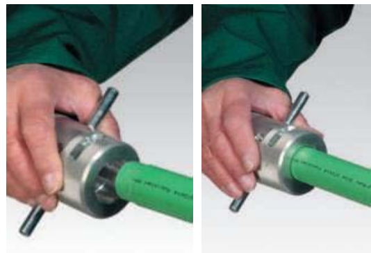
Odrezanie stabilizačnej vrstvy Al-PP (odpadá u potrubia fusiotherm® a fusiotherm® s vláknami)
